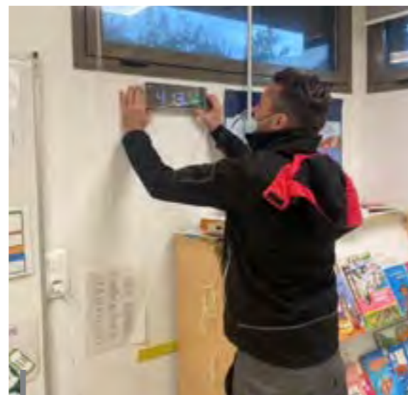
L'ensemble des classes des différentes écoles, les cantines ainsi que tous les services accueillant du public sont désormais équipés de capteurs de CO2. Les élèves guettent désormais le petit voyant rouge indiquant que la pièce doit être aérée !
