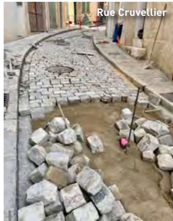
La première tranche des travaux de rénovation de la rue Cruvellier, réalisés par la Métropole, a été réalisée : après retrait temporaire des pavés, le fond de forme a été créé, pour une nouvelle pose des pavés sur une base saine. Cette première tranche concerne la partie basse, la plus abîmée, de la rue, entre l'église et le Riau. La seconde tranche, en partie haute, sera réalisée courant 2022.
