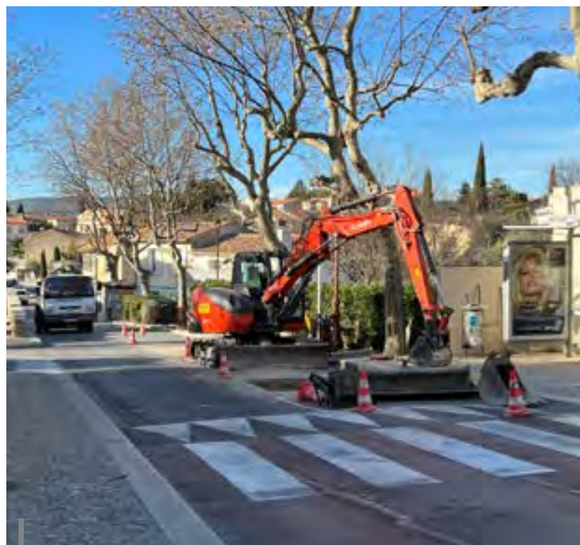
Pour garantir le meilleur service de distribution, la Société des Eaux de Marseille Métropole renouvelle son réseau d'eau potable sur la Commune, plusieurs chantiers sont en cours et ce, jusqu'au mois de Mai : un premier chantier de l'avenue Eugène Julien jusqu'au Boulevard Alphonse David, en passant par la Traverse de la Grande Bastide, et un second au Chemin Sainte Brigitte, du Funérarium jusqu'au chemin de Moulin Mouriers.
