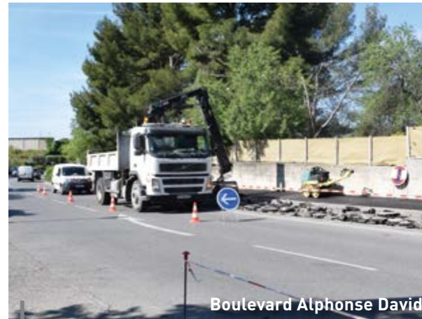
Boulevard Alphonse David Réalisée par la Métropole, la rénovation des trottoirs du Boulevard Alphonse David a vu sa seconde tranche effectuée au mois de Mai. Le revêtement, devenu lisse avec le temps, était devenu dangereux les jours de pluie, notamment pour les enfants qui attendent le car scolaire le matin, ainsi que les patients du cabinet médical.
